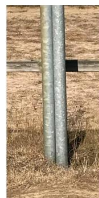
Grondbuis verankering, grondbuis zit tot op 1.50 m + maaiveld in de grond gedreven.
