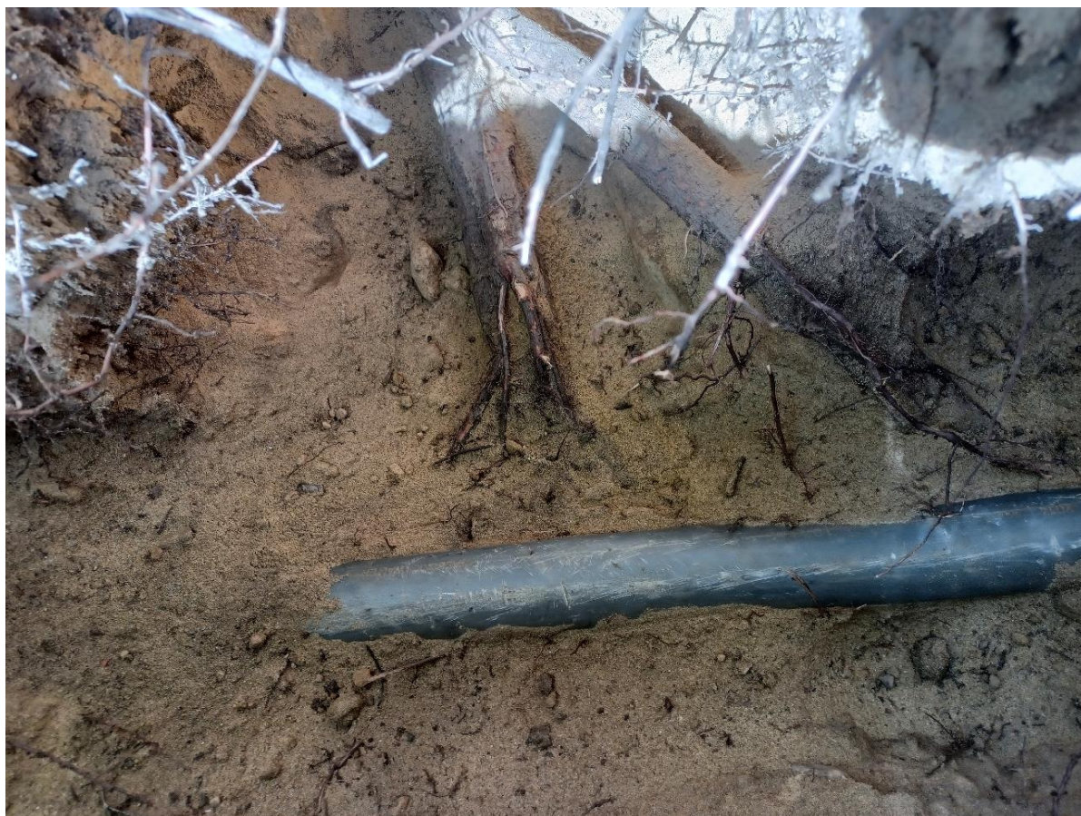
Afbeelding 3.11 Mantelbuis in profielsleuf 3
