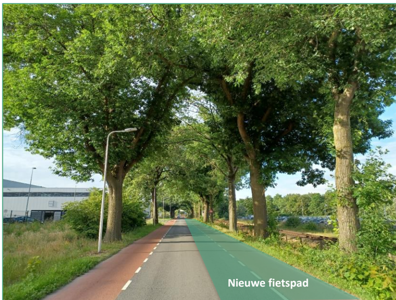
Afbeelding 4.7 opbreken huidig asfalt en situatie nieuwe fietspad
