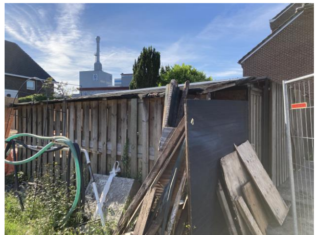
Foto 12 Aanzicht op het tijdelijk opgericht schuurtje ten noorden van de woning gelegen aan de Spoorstraat nr. 63
