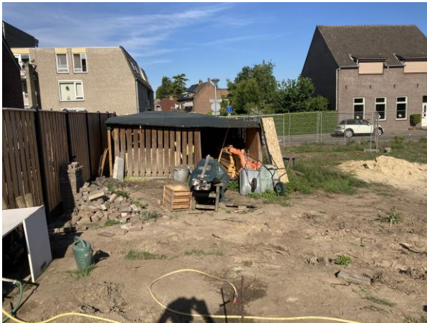
Foto 7 Aanzicht vanuit de zuidoost hoek naar het tijdelijk opgericht schuurtje
