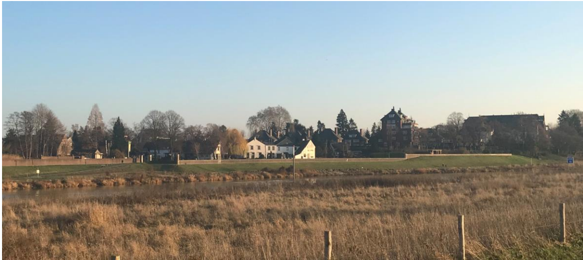
Figuur 2. Foto van het plangebied genomen van de overzijde van de Maas, het demontabele deel van de kering betreft de lager gelegen stenen muur in het midden van de foto. (Foto Koos Mol, 13-12-2018).
