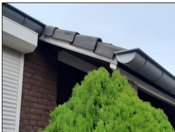
Figuur 10. Detail dakrand en dakgoot.
