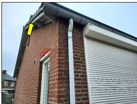
Figuur 12. Stootvoegen (rood omcirkeld) en invliegopeningen onder dakpannen (gele pijl).
