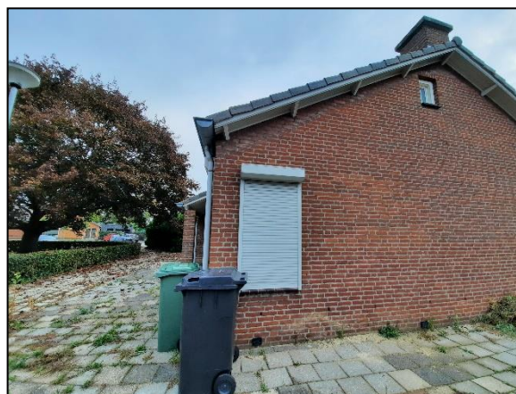
Figuur 11. Detail zijgevel, dakrand en dakgoot.
