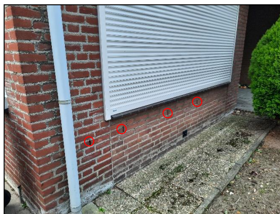
Figuur 13. Stootvoegen die duiden op de aanwezigheid van een spouwmuur.
