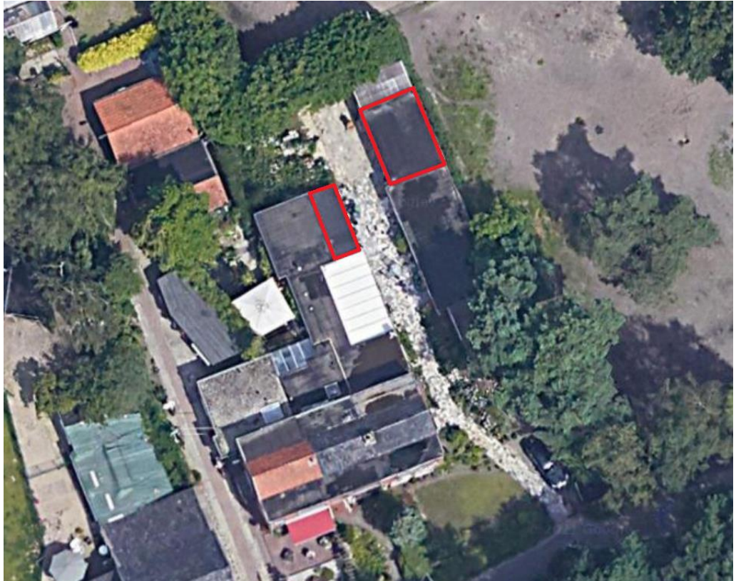
Figuur 4. Te slopen bebouwing (rood omkaderd).
