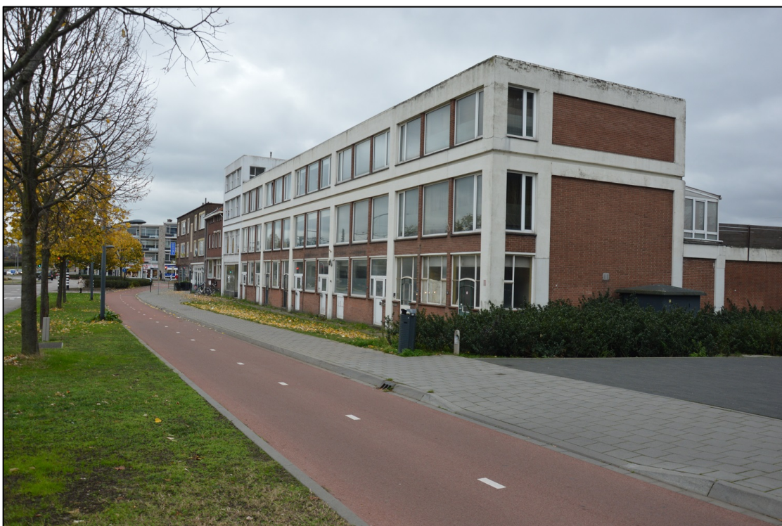
Afbeelding 24: foto met zicht op het te slopen gebouw op de hoek Eindhovenseweg-Veilingstraat
