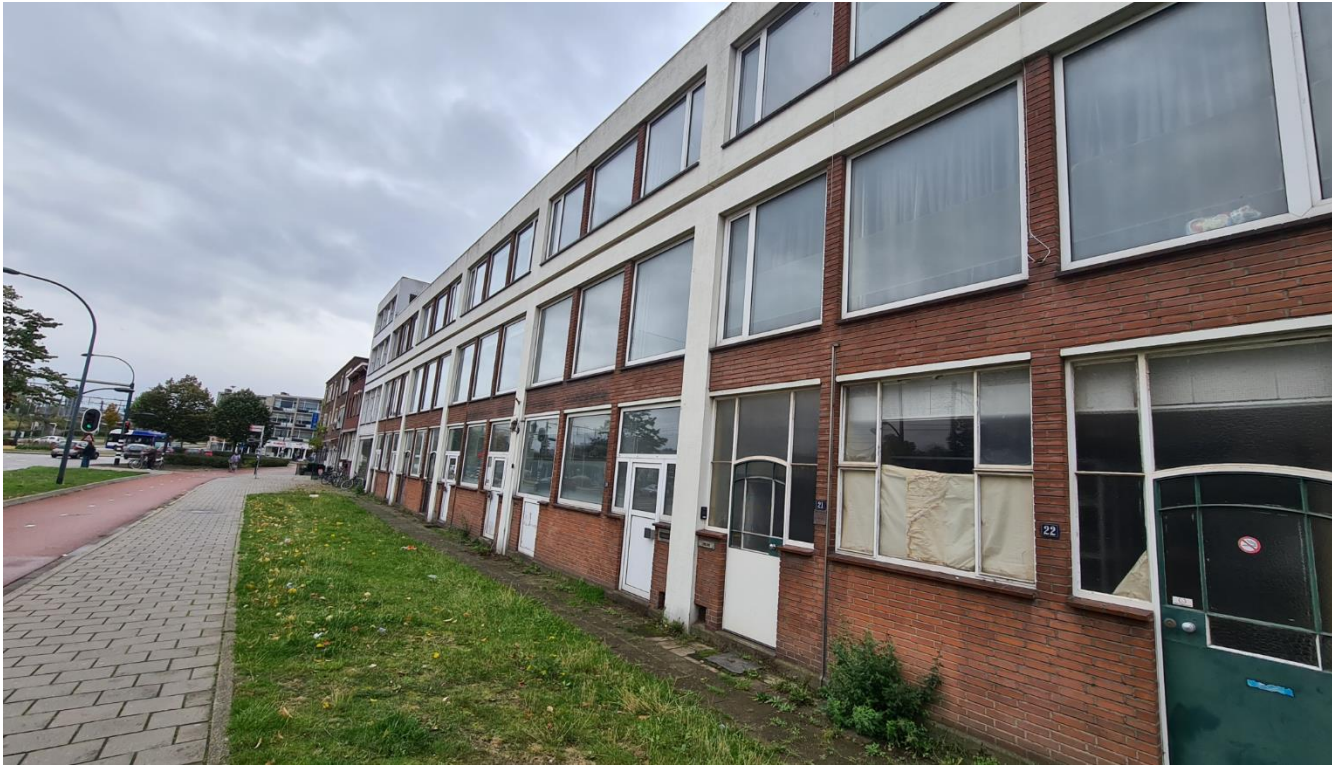
Figuur 4: Appartementencomplex gezien vanuit het noorden, vanaf de Eindhovenseweg
