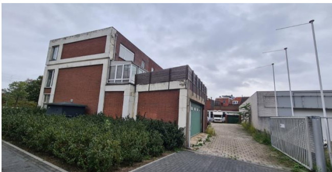
Figuur 7: Appartementencomplex gezien vanuit het westen, vanaf de Veilingstraat
