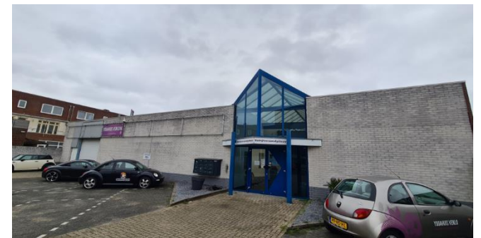
Figuur 9: Westgevel van de Bedrijfsloods
