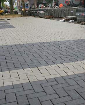
referentiebeelden bedrijfsdeel; links; verharding betonstraatsteen (aanduiding stalling containers met andere kleur) midden; opslag materiaal tussen beton stapelblokken rechts; vergroenen gevel
