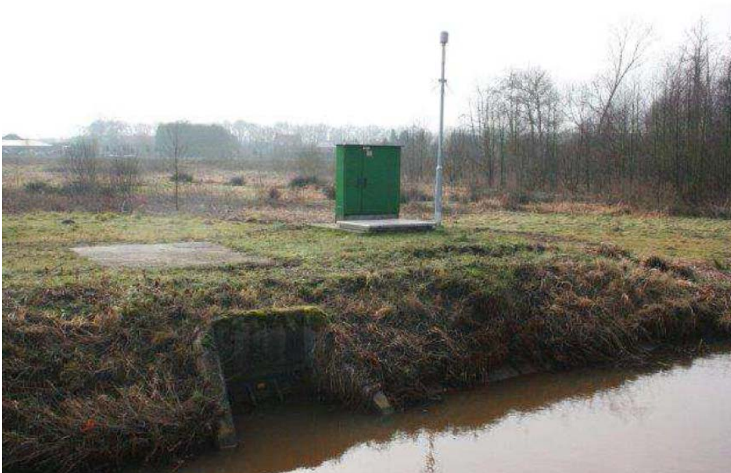
Afbeelding 3: Bestaande overstort met pomplocatie
