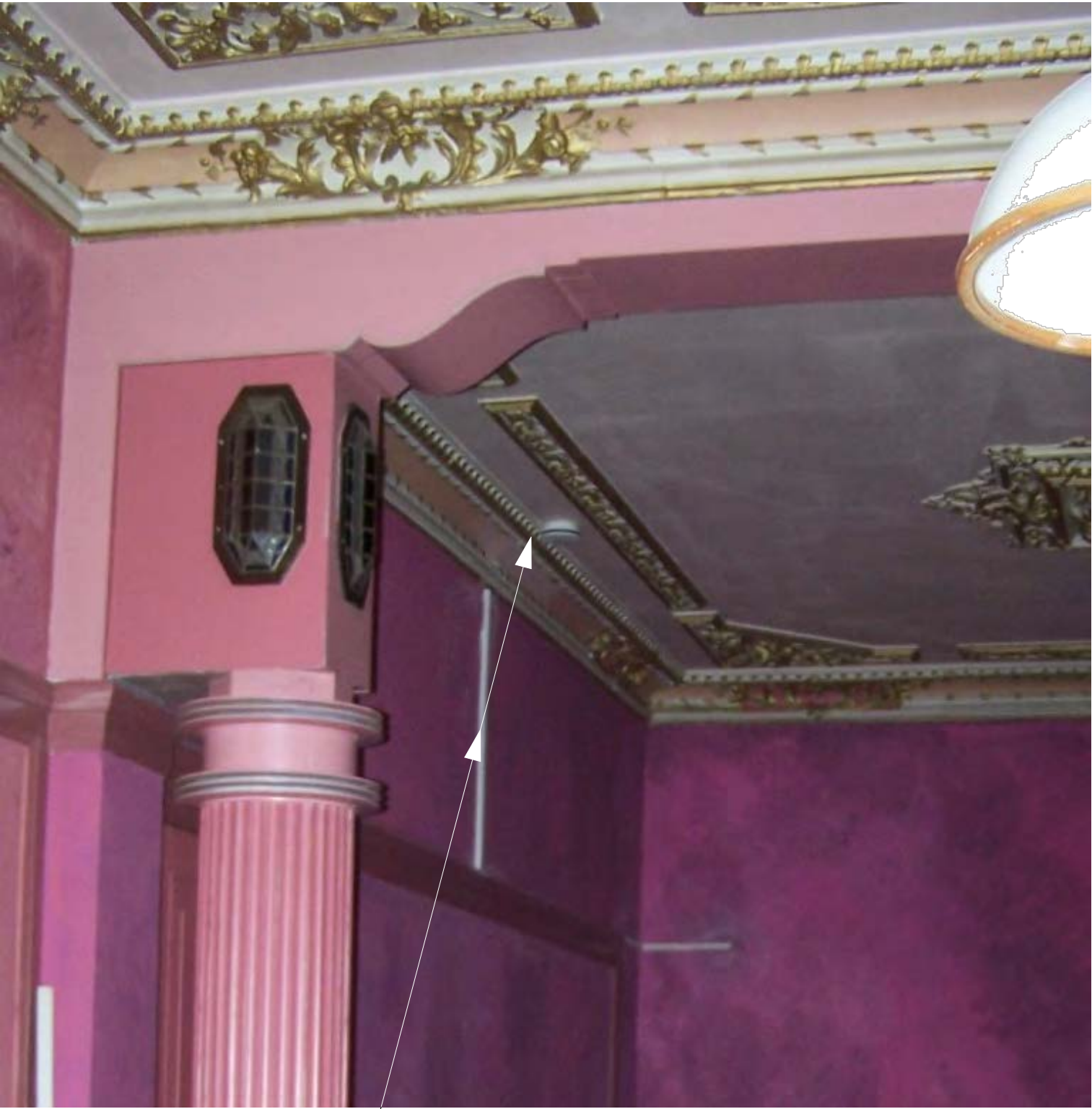
Foto 1. Brandmeider incl. toevoer electra via kabelgoot
