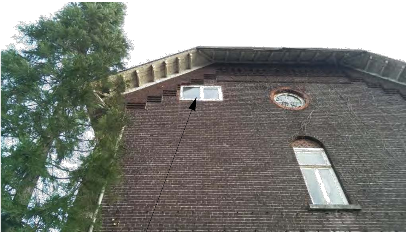
Foto 2. Het kunststof kozijn in de topgevel wordt vervangen door een houten kozijn
