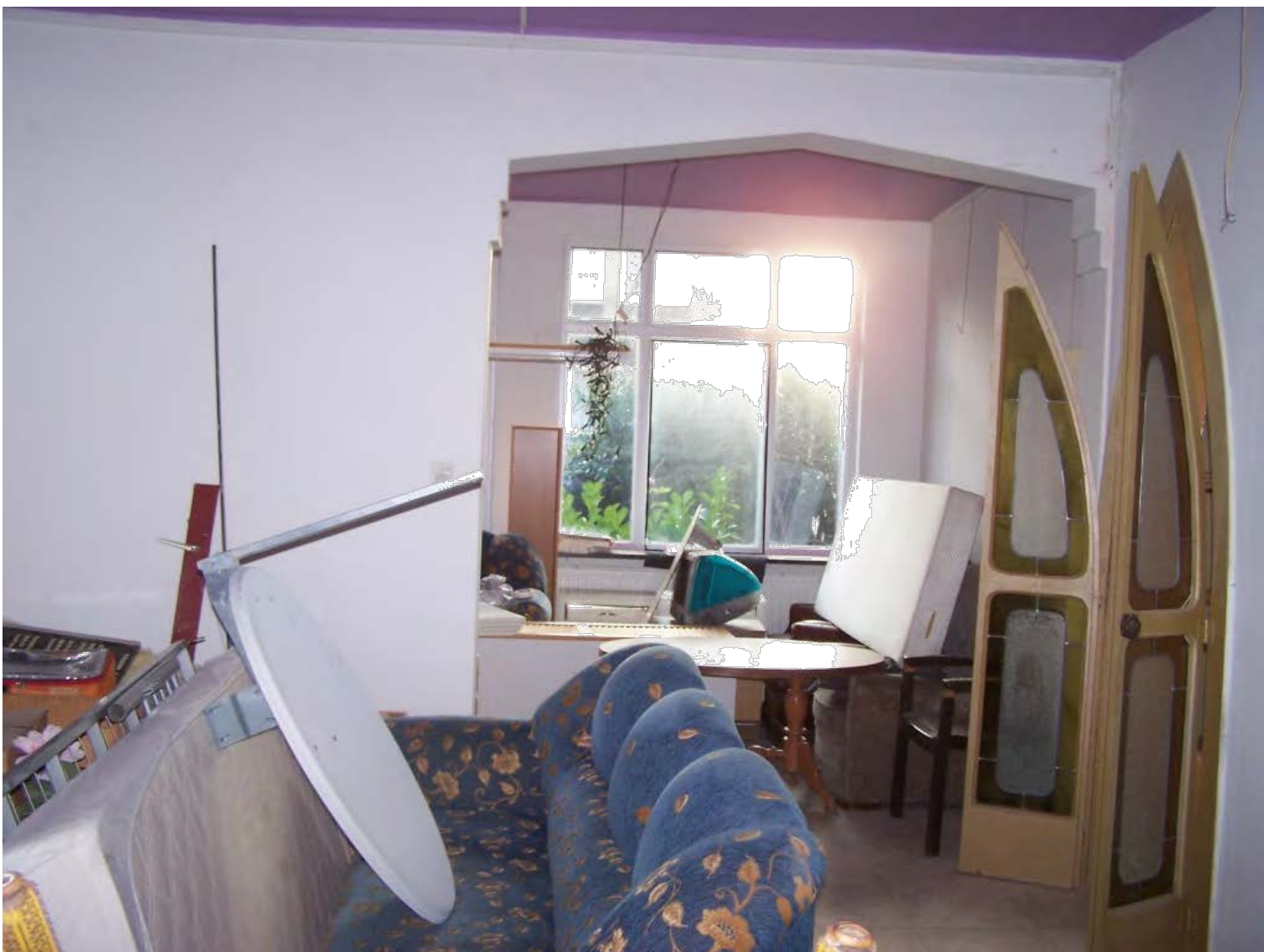
Foto 7. Dicht te maken opening
