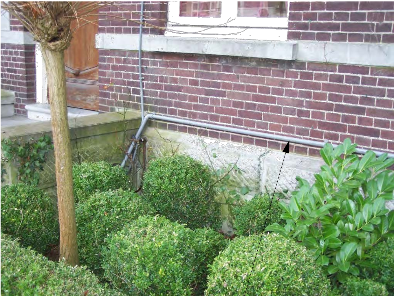
Foto 4. pvc buis van gevel verwijderen en invoer in de grond verslepen
