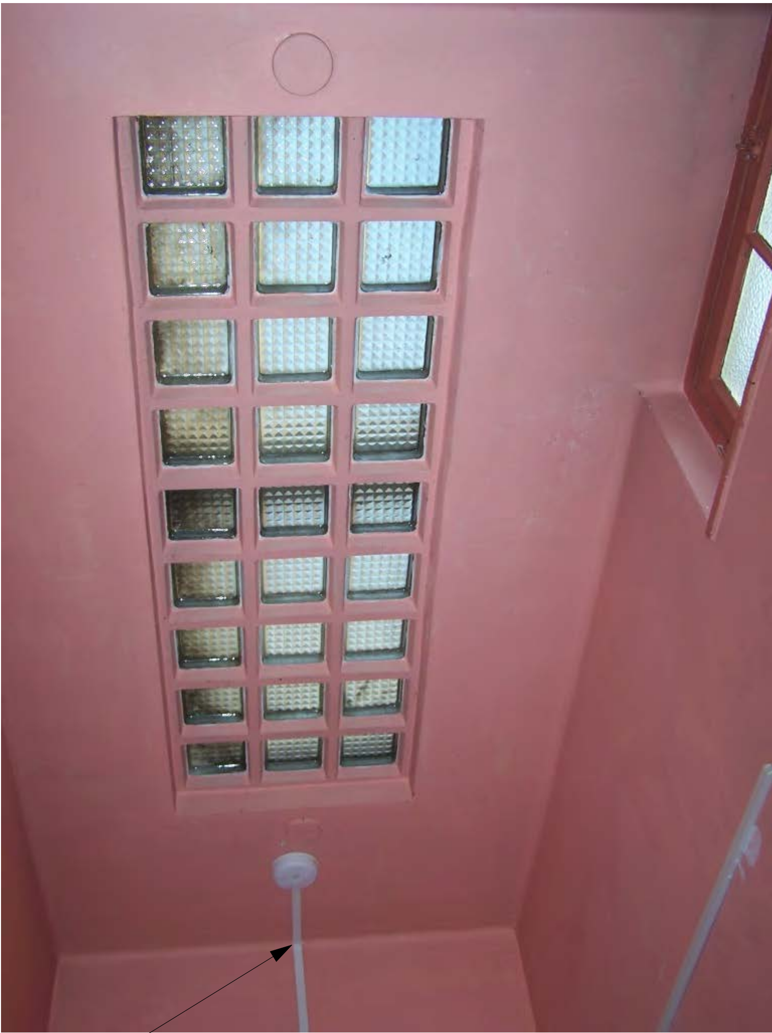
Foto 4. Brandmeider incl. toevoer electra via kabelgoot
