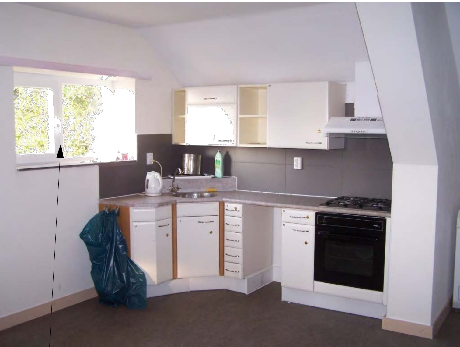
Foto 5. Te vervangen kunststof kozijn door een houten kozijn
