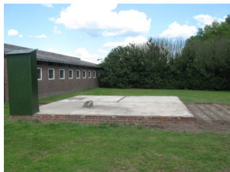
Foto 6. Betonnen fundering van reeds gesloopt gebouwtje, gezien in oostelijke richting.
