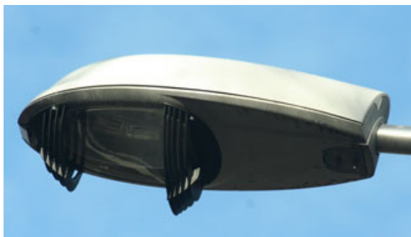
Afb. 4: Compacte armatuur met lichthinderkap die de hoeveelheid strooilicht significant beperkt.
