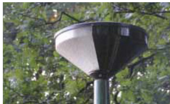
Afb. 5: Straatverlichting met aangepast armatuur. In dit geval is de helft van de lamp afgeschermd waardoor licht niet onnodig richting bomen schijnt.
