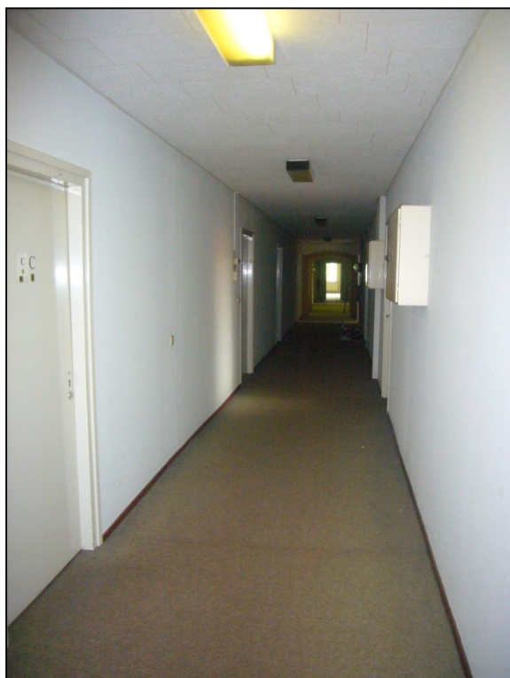
Afbeelding 20 – gang in noordelijke vleugel, eerste verdieping.
