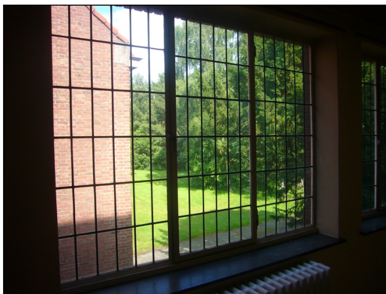
Afbeelding 9 – origineel glas- in-lood in stalen vensters op de eerste verdieping boven de kruisgang (1929).
