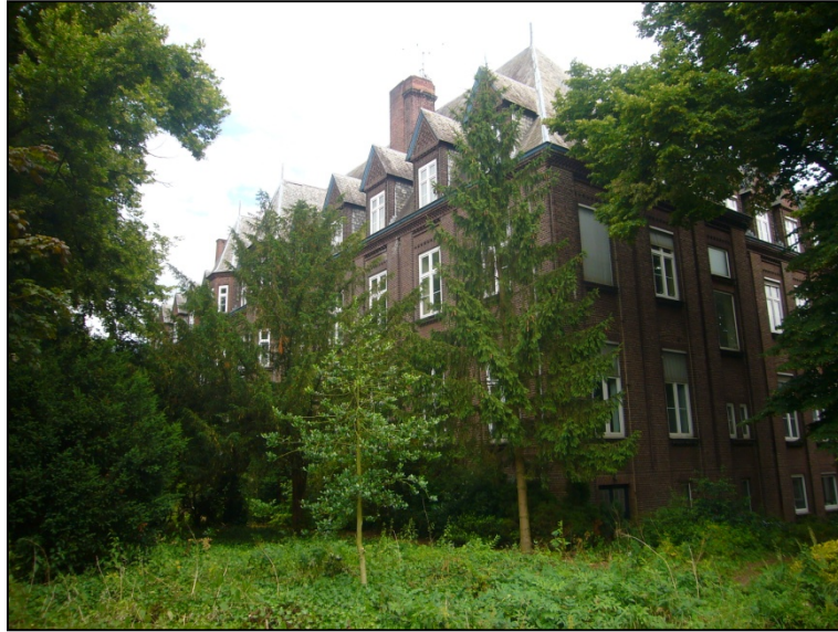
Afbeelding 3 – noordwestelijke hoek van de noordwestvleugel.
