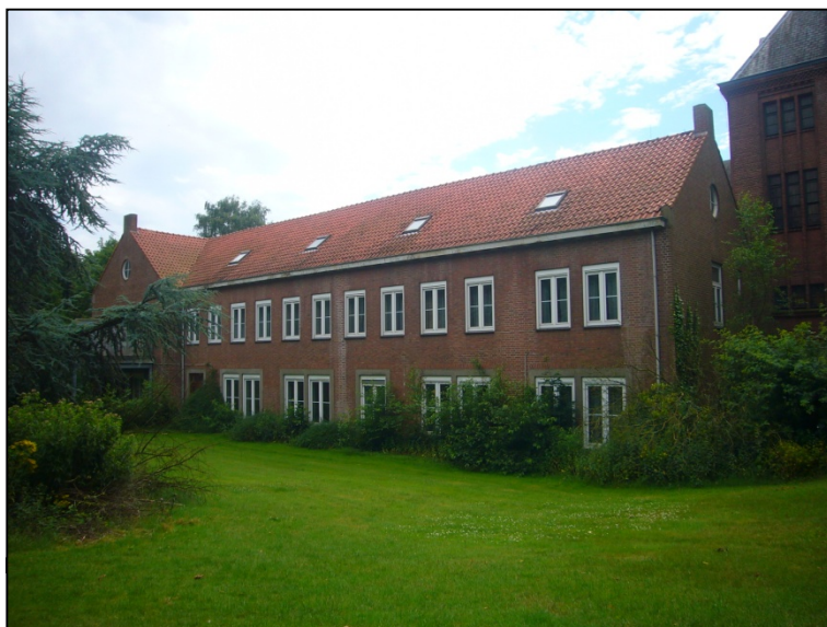
Afbeelding 7 – oostelijke langsgevel van oostelijke vleugel.
