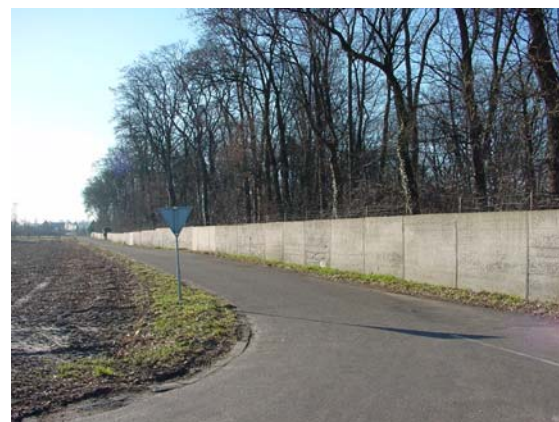
Betonnen omheining aan de Beckersweg
