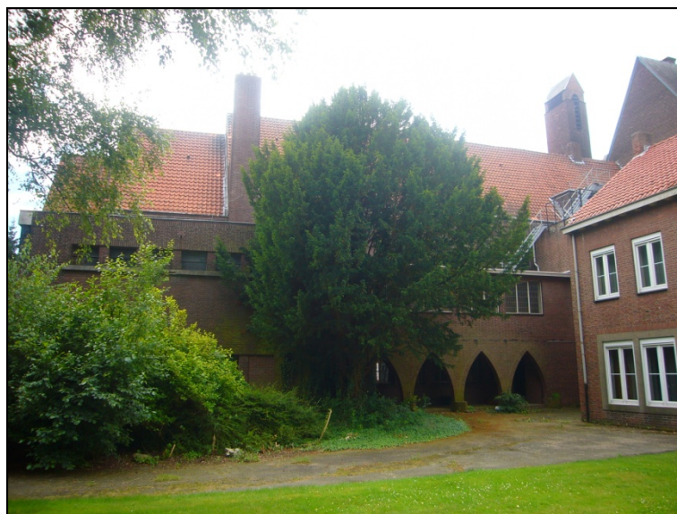
Afbeelding 6 – aansluiting van de kapel en de zuidelijke vleugel
