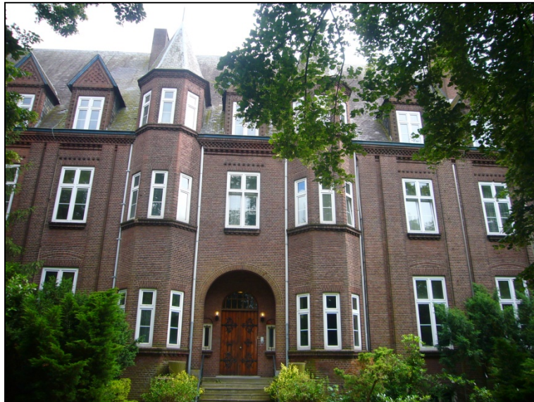
Afbeelding 4 – oorspronkelijke entree in de noordelijke langsgevel. Door niveauverschil van maaiveld kent de noordelijke zone een souterrain met bel-etage, de zuidelijke zone een begane grond en verdieping op vergelijkbaar niveau.
