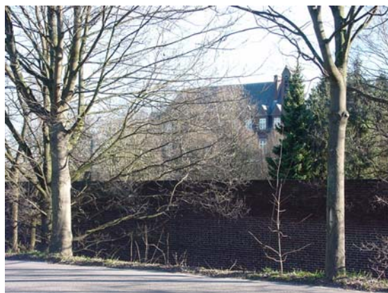
Hoge bakstenen ommuring aan de Kaldenkerkerweg
