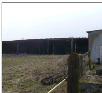
te slopen opstal
