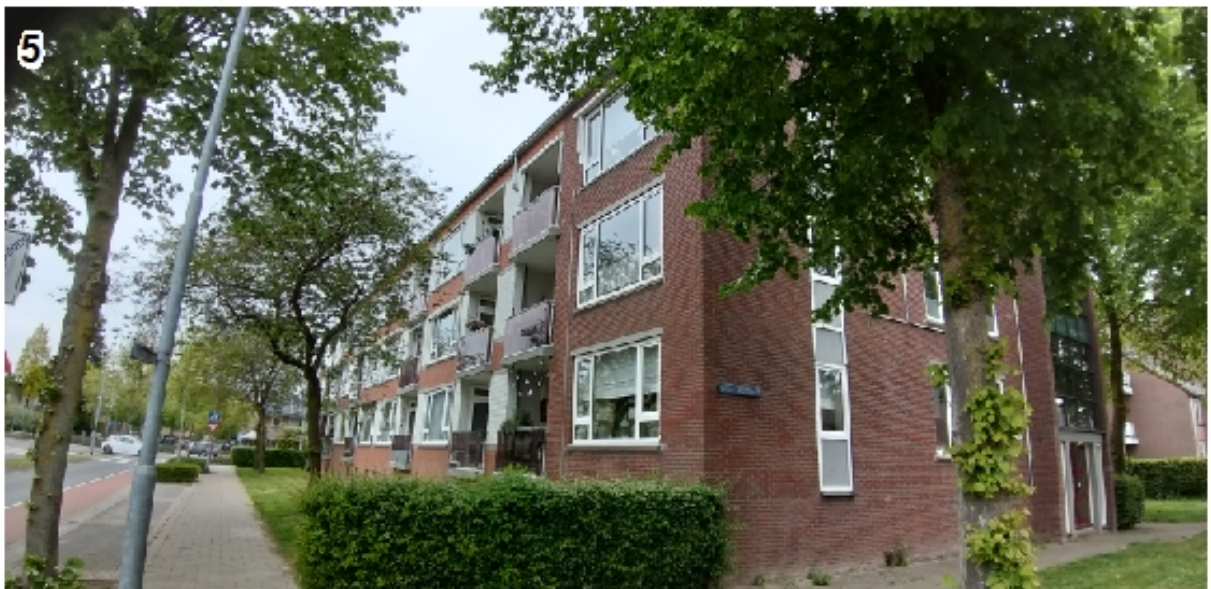
Foto's 1-5: Appartementencomplex Burg. Gommansstraat 177-221, Blerick
