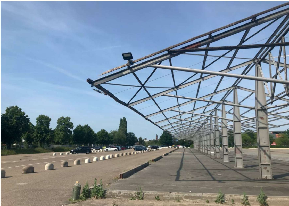
Figuur 1 De stalen constructie van het oude veilingterrein is de blikvanger van het gebied.
