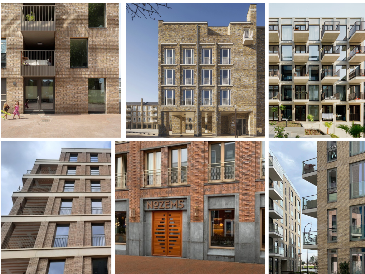
Materiaal, kleur, textuur, detaillering gevels
