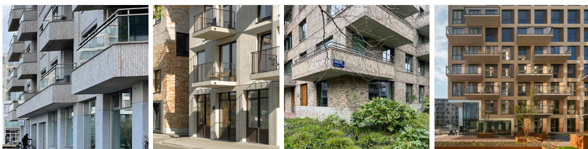
Plastiek in de gevel door middel van buitenruimtes van de woningen
