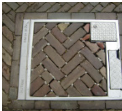
Putkast ingepast in verharding
