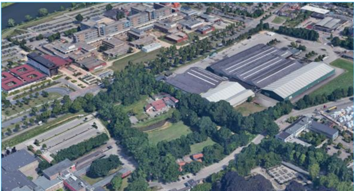
Figuur 1.1: luchtfoto huidige situatie
