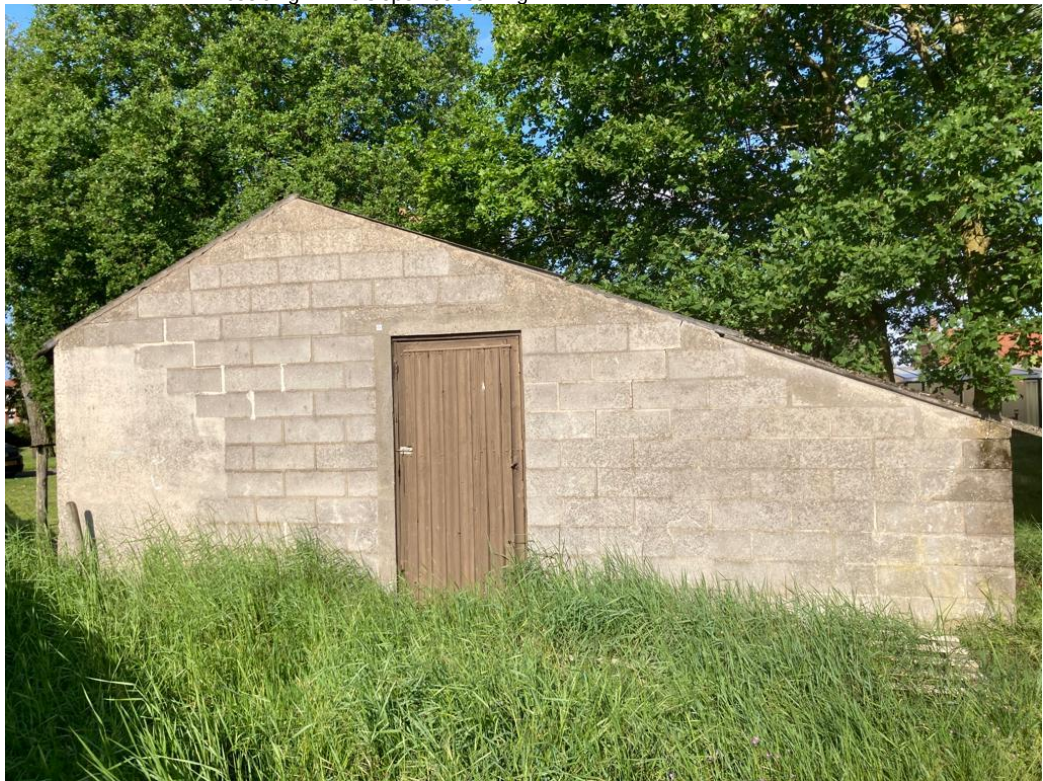
• Afbeelding 12: Te slopen bebouwing
