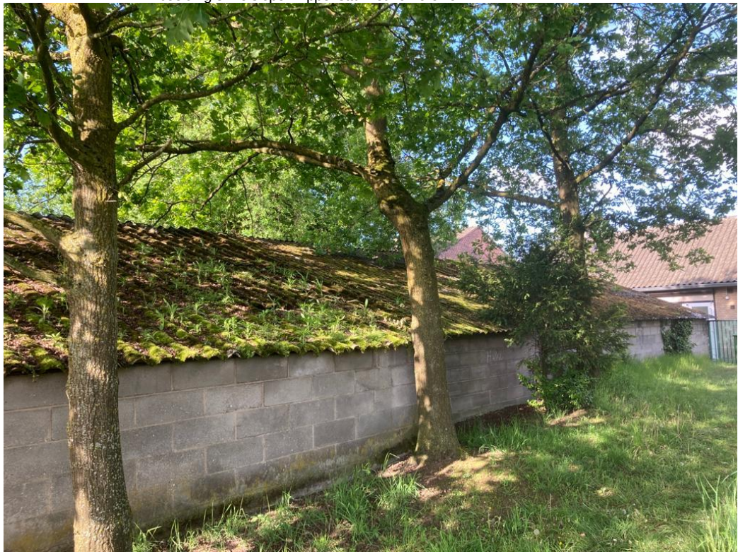
• Afbeelding 8: Te slopen kippenstal met zomereiken
