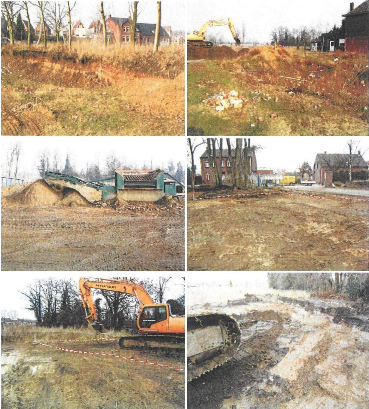
Figuur 14: Fotomateriaal van de bodemsaneringswerkzaamheden 2005.
