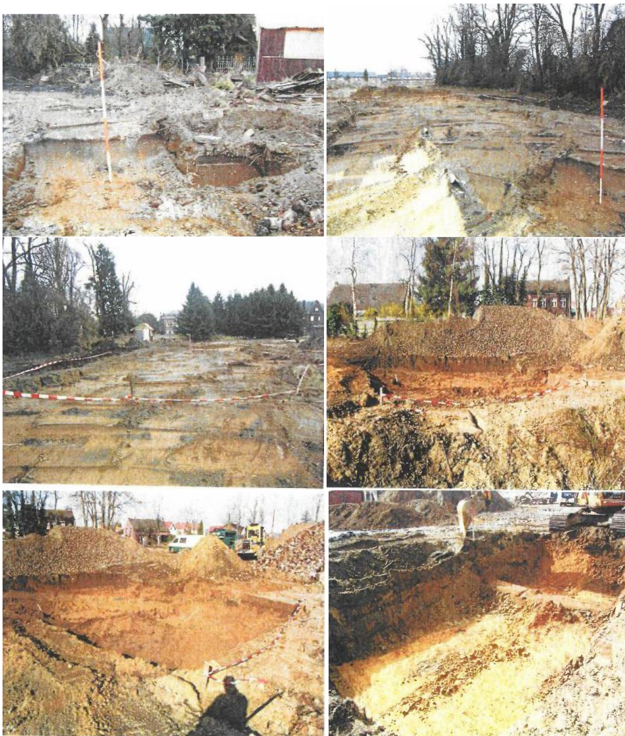
Figuur 15: Fotomateriaal van de bodemsaneringswerkzaamheden 2005.
