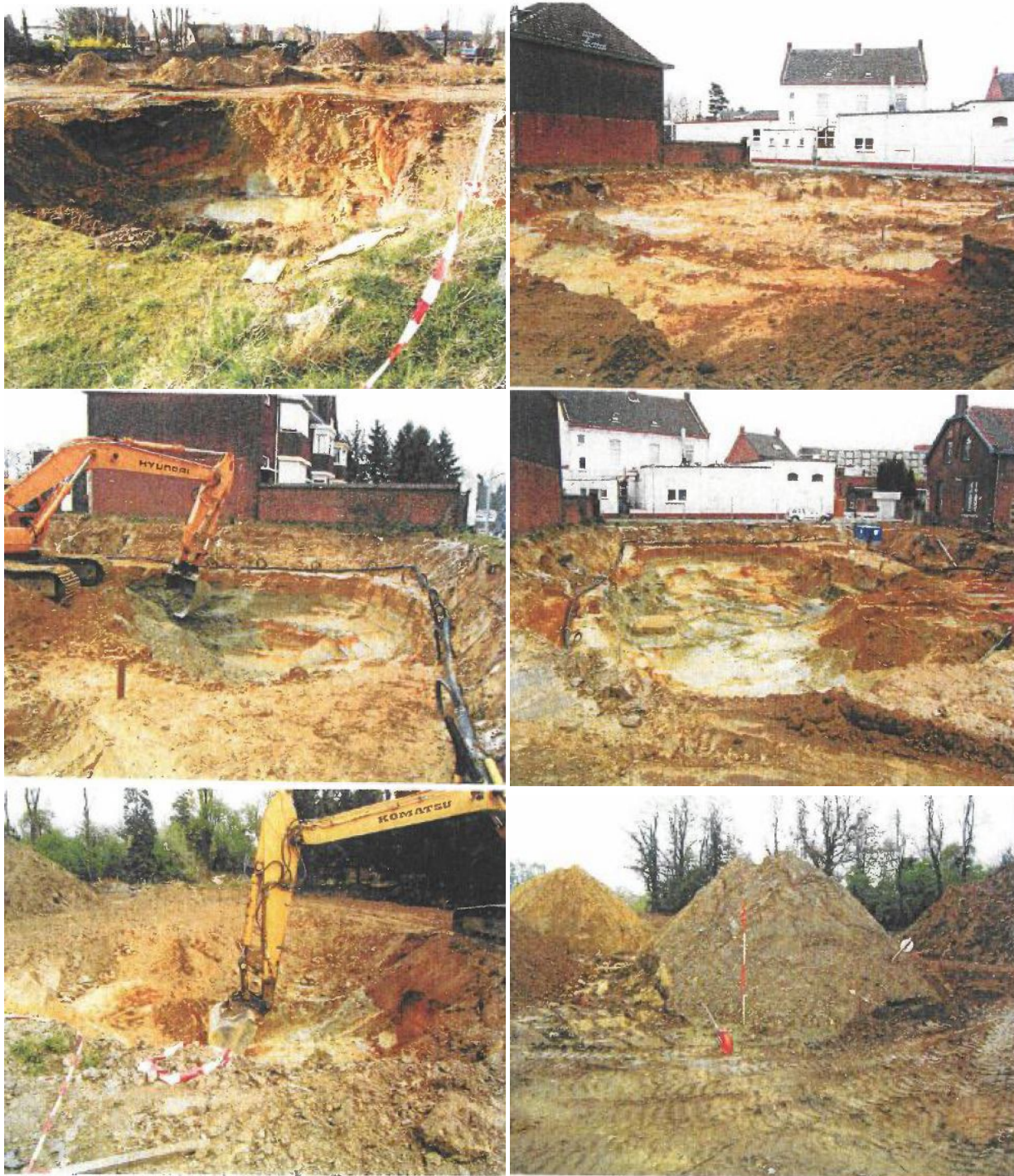
Figuur 16: Fotomateriaal van de bodemsaneringswerkzaamheden 2005.
