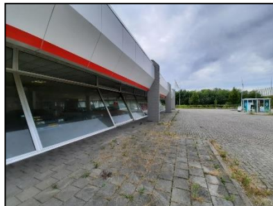
Figuur 4. Impressie voormalige autogarage op planlocatie.
