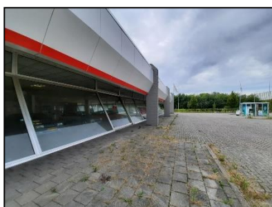
Figuur 3. Impressie voormalige autogarage op planlocatie.
