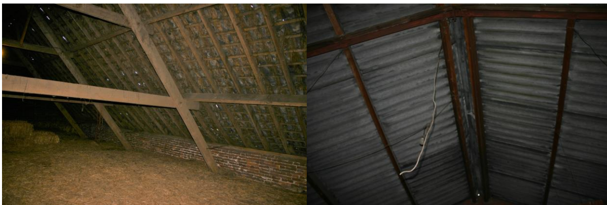
Figuur 4.4.3. De enkelwandige daken van de woonboerderij (l) en halfopen schuur (r).
