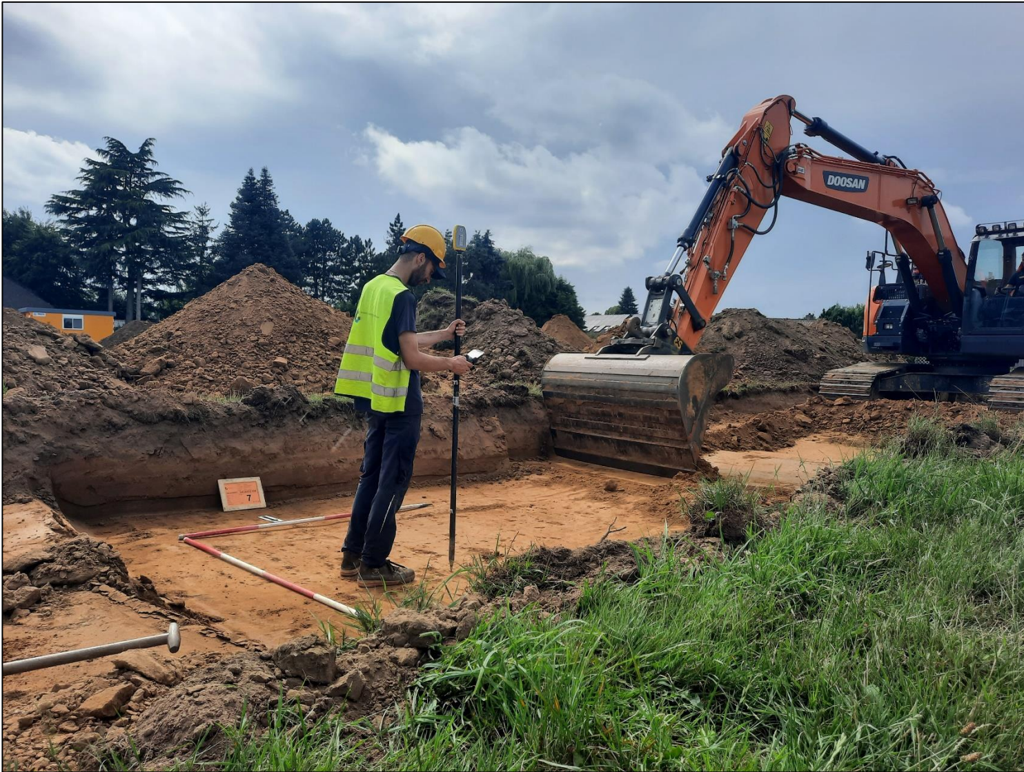
Figuur 3. Sfeerfoto van de aanleg van werkput 4.
