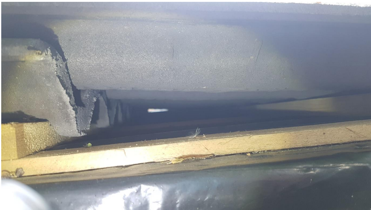
Foto 29: controle onder de dakpannen van het schuurtje.
