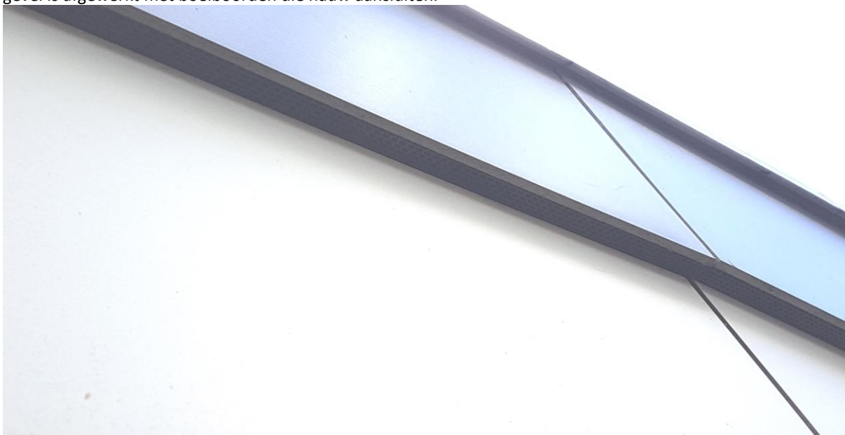
Foto 2: de ruimte tussen de platen zijn afgewerkt met een rooster zodat hier niks tussen kan kruipen.
