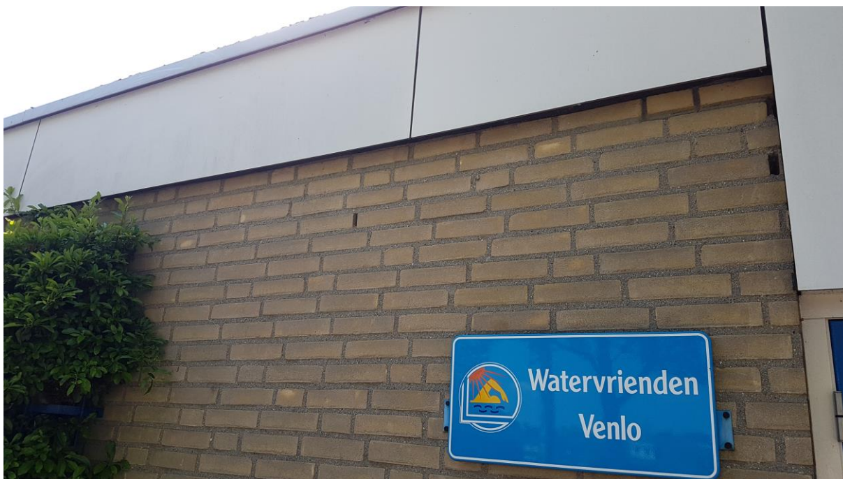
Foto 23: de openstootvoegen beginnen vanaf de "Watervrienden Venlo" en lopen door tot en met het noordelijke deel.
