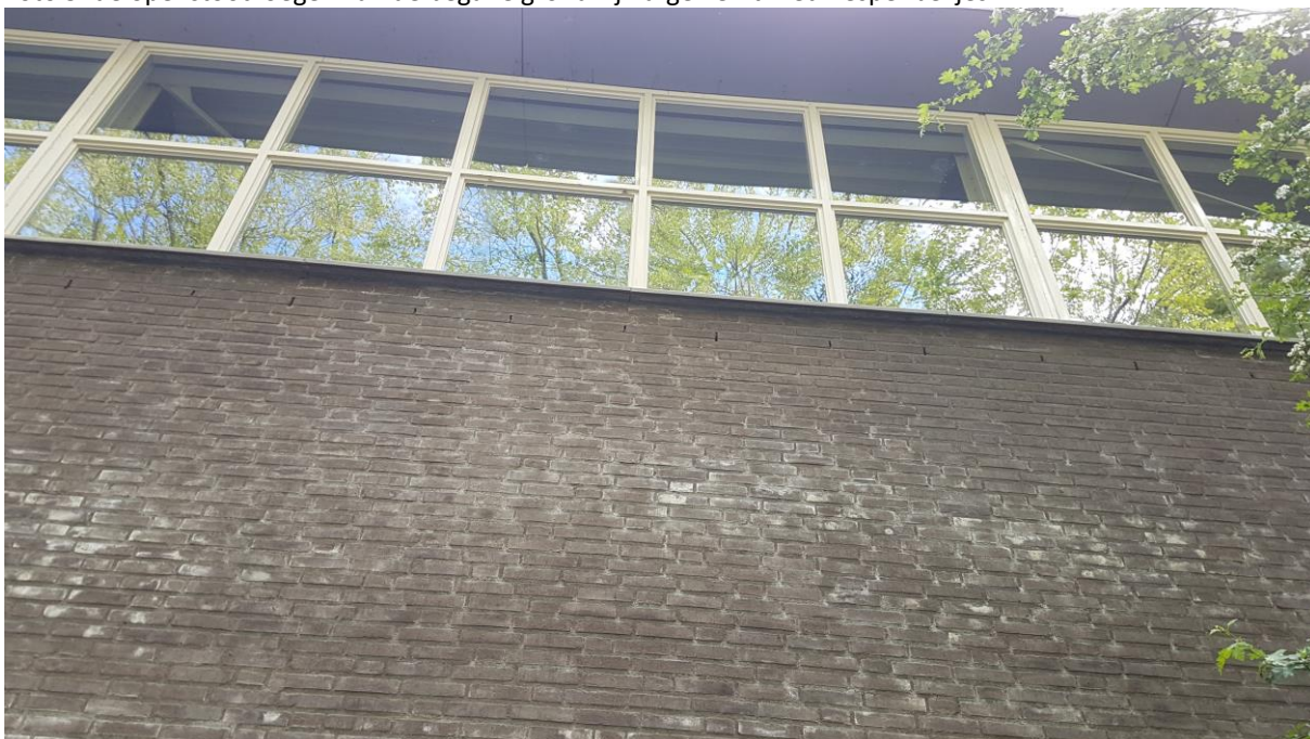
Foto 6: de openstootvoegen op de 1 ste verdieping zijn niet afgewerkt met wespenbekjes waardoor dit een verblijfplaats biedt voor vleermuizen.
