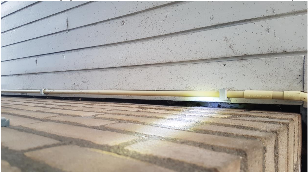
Foto 4: een detail foto van het witte houtenplafond en de aansluiting met de muur waar een spleet en ruimte tussen zit.
