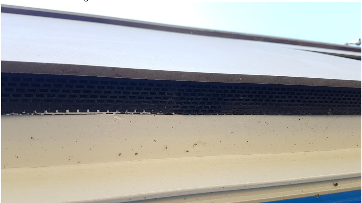
Foto 22: de ruimtes tussen de boeiboorden zijn afgewerkt met roosters.
