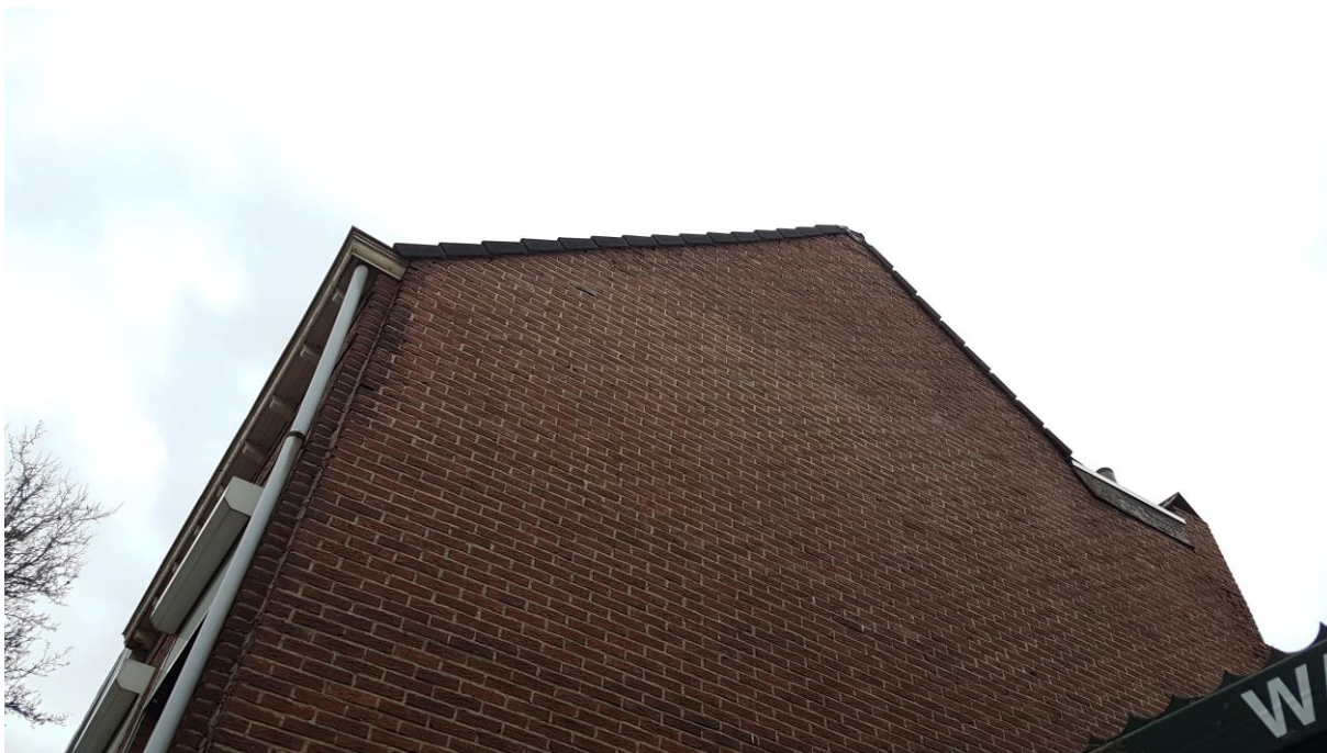
Foto 7: de dakranden sluiten na inspectie netjes aan.
