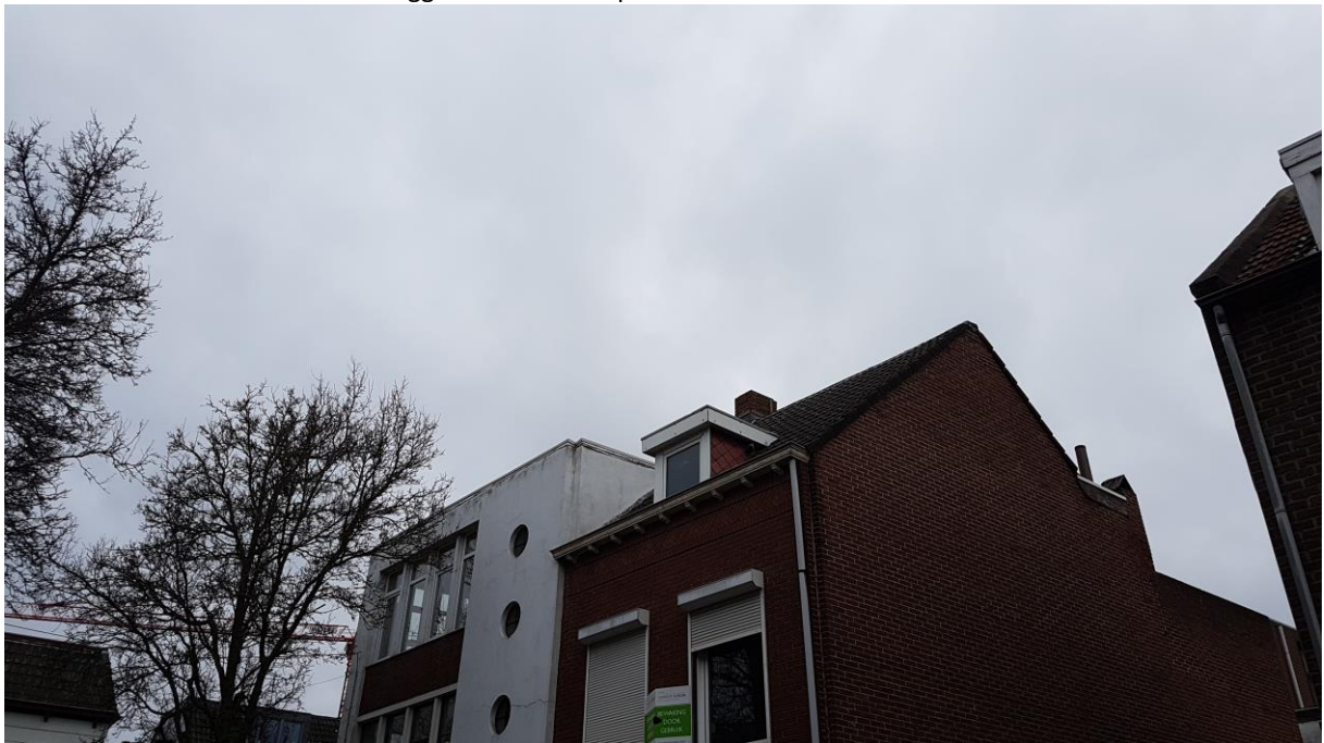
Foto 4: het woonhuis aan de Ginkelstraat 3.
