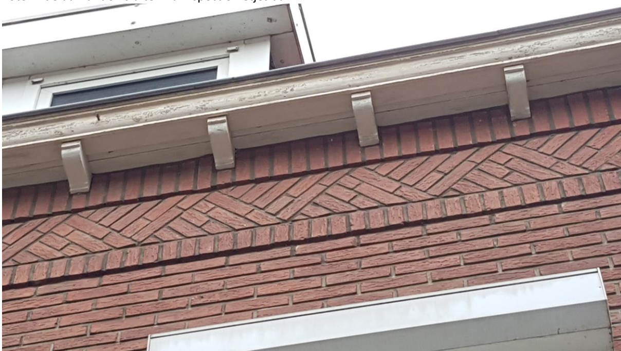
Foto 8: het houtwerk sluit aan tegen de bakstenen waardoor hier geen openingen zijn.
