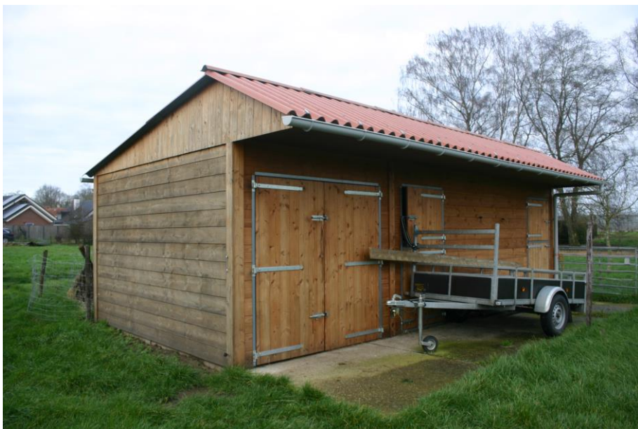
Figuur 4.2.1. De schapenstal in de wei is de enige bebouwing in het plangebied.
