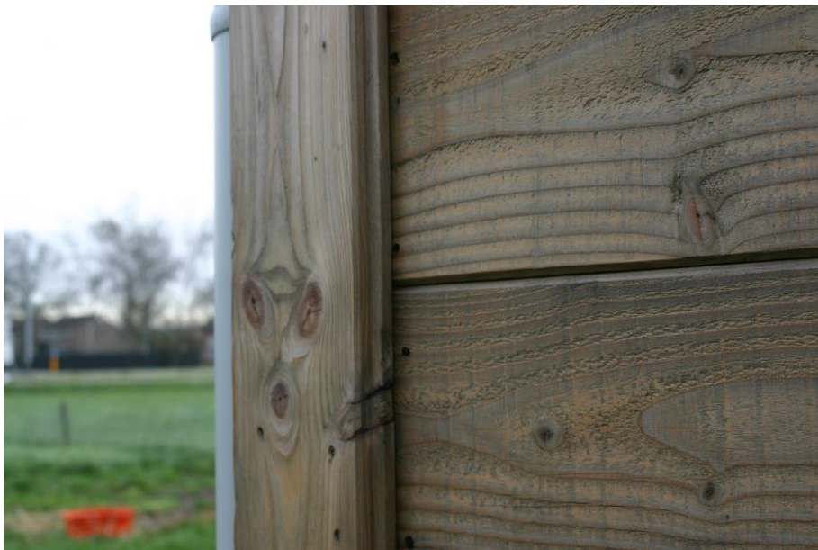
Figuur 4.2.2. De houten gevelbekleding sluit overal nauw aan, waardoor vleermuizen geen achterliggende holtes kunnen bereiken.
