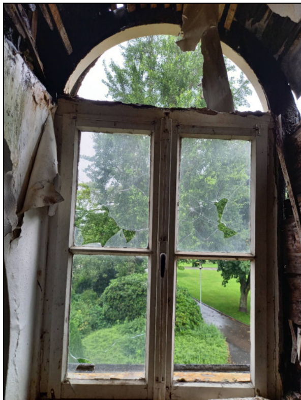
Foto 10: opening boven en rechts onder
