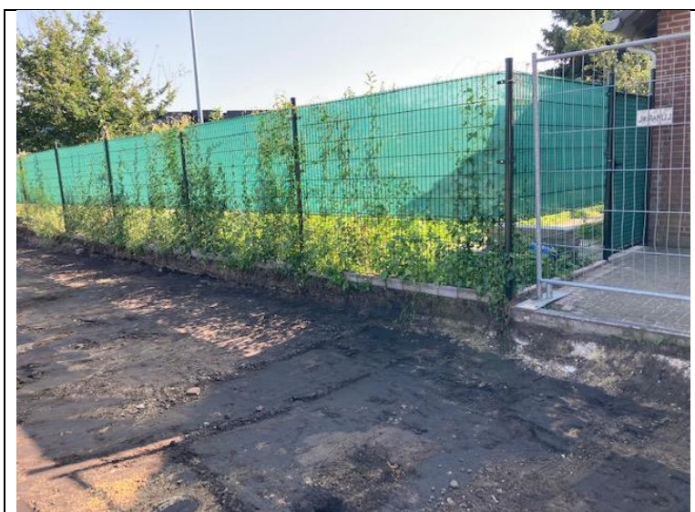
Foto 8: ontgraven tot aan de perceelsgrens
