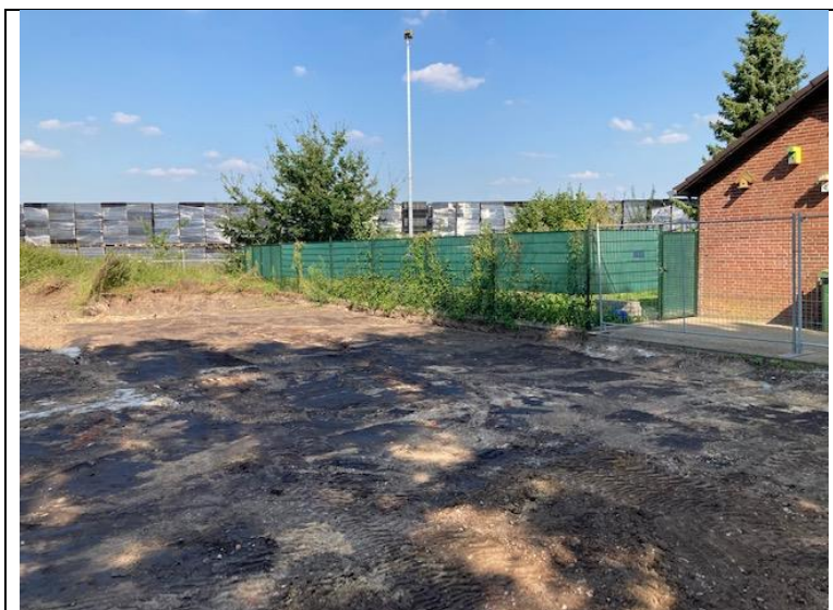
Foto 10: overzicht ontgraving bodem B7 en B6
