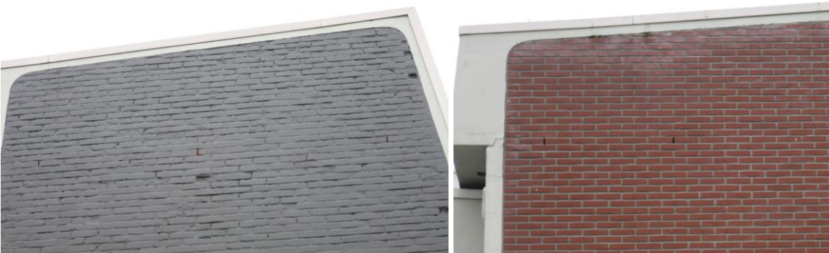
Nieuwe vleermuisopeningen in bestaande gevels.
