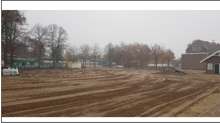
Foto 15: Voormalige parkeerplaats bij gebouw V
