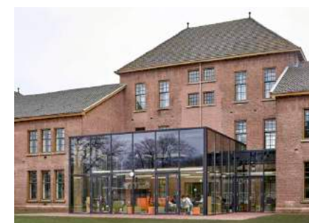
Tapijnkazerne Maastricht voor en na restauratie
