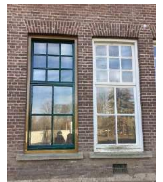
restauratie bestaande houten kozijnen Tapijnkazerne
