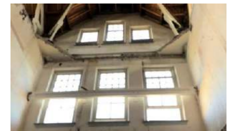
na verwijdering verlaagde plafond Tapijnkazerne
