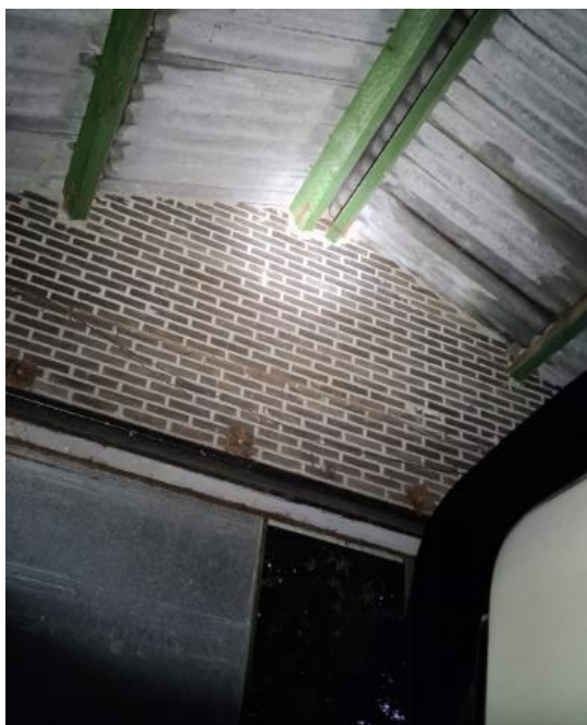
Figuur 2: Binnenzijde opstal
