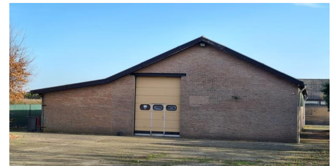
Figuur 9: Opstal gezien vanuit het oosten
