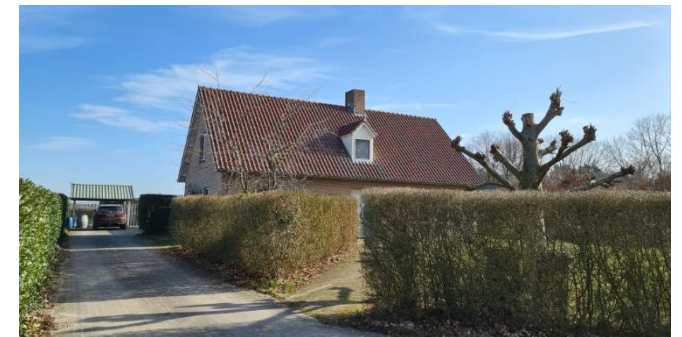
Figuur 6: Woonhuis gezien vanuit het oosten
