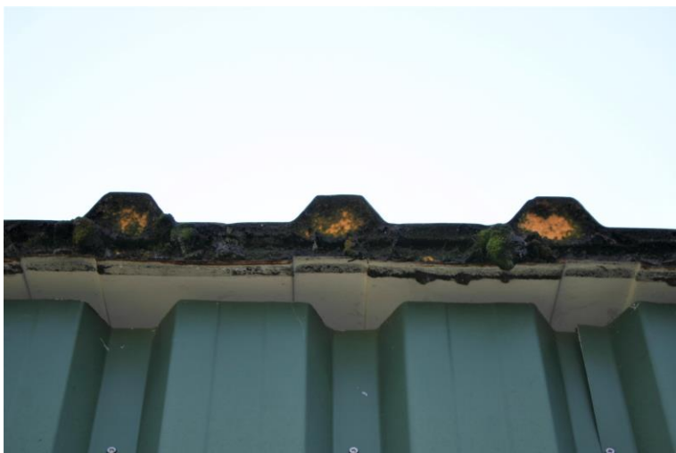
Figuur 4.2.1. In het sandwichpanelen dak is geen ruimte voor vogelnesten of vleermuisverblijven. Het dak sluit nauw aan op de gevels.
