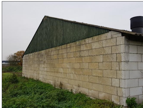
Figuur 5. Achterkant middelste schuur
