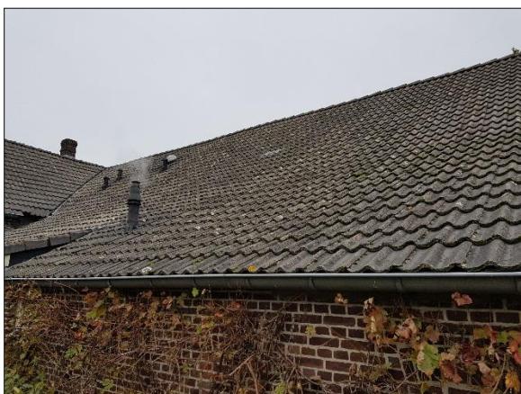
Figuur 8. Buitenkant te verbouwen gebouw
