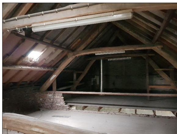
Figuur 9. Binnenkant te verbouwen gedeelte
