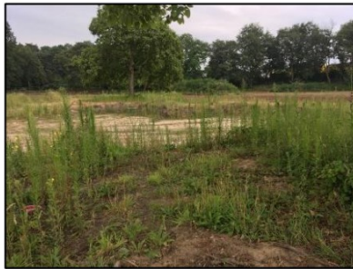
Figuur 3. Zuidelijk deelgebied, kijkrichting westelijk.
