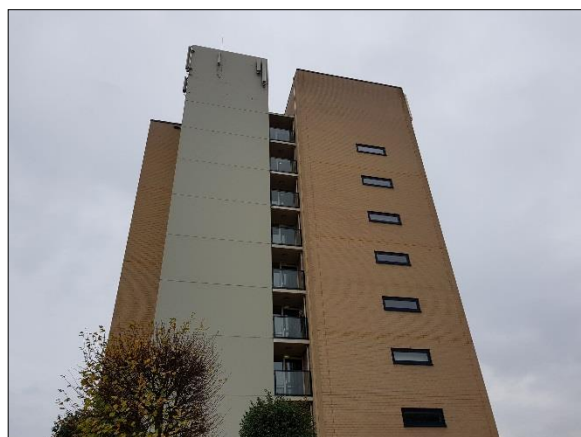
Figuur 4. Toren van het hotel van noordzijde
