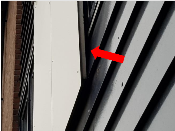
Figuur 13. Ruimte achter platen tegen gevel, aan meerdere zijdes.
