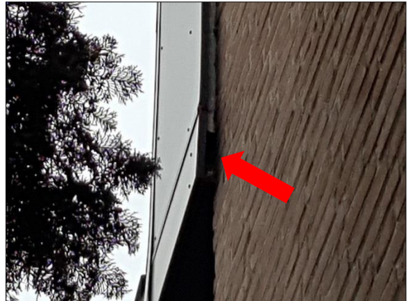
Figuur 14. Opening in dakbetimmering, oostzijde
