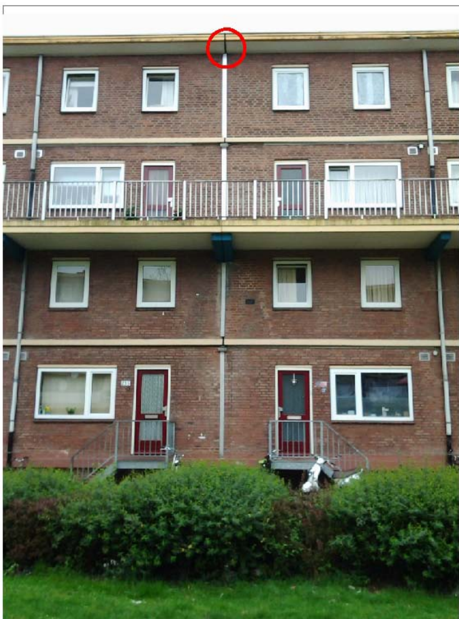
Foto 1: Voorbeeld van spleet in gevel/dakrand
