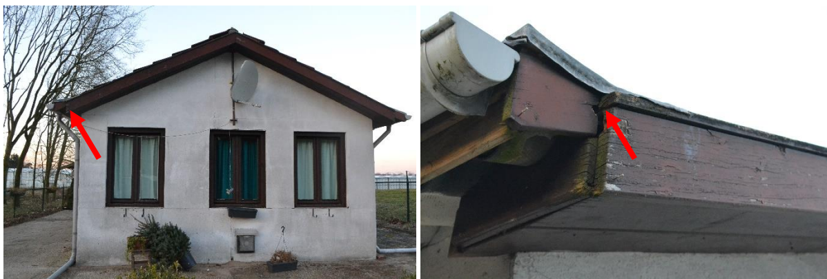
Figuur 3.1 Situatie van de bedrijfswoning. Zichtbaar bij de pijl is een holle balk die via het gat bereikbaar is voor vleermuizen.
