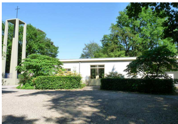
Figuur 8. Het bijgebouwtje, gezien vanaf de begraafplaats. Foto genomen richting het oosten.
