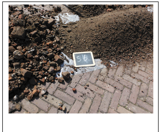
Foto 12. Opgegraven en gezeefd materiaal inspectiesleuf S06
