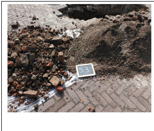
Foto6. Opgegraven en gezeefd materiaal inspectiesleuf S03
