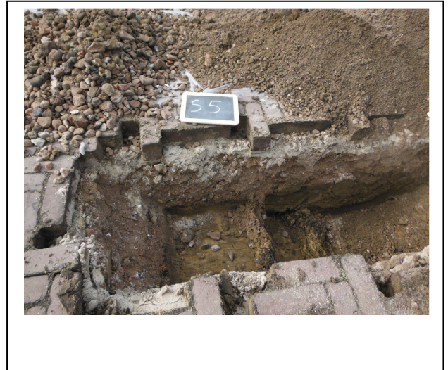
Foto 10. Opgegraven en gezeefd materiaal inspectiesleuf S05
