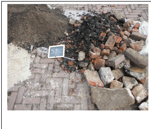
Foto 2. Opgegraven en gezeefd materiaal inspectiesleuf S01
