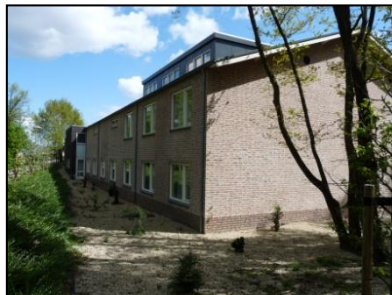
Figuur 4. Westzijde hotel Maashof waar nieuwbouw aanvast wordt gekoppeld.
