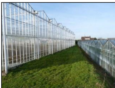
Figuur 6. Onderzoekslocatie links en aangrenzende kas rechts.
