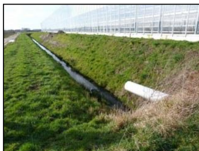
Figuur 7. Afwateringsgreppel, oostelijk deel onderzoekslocatie.
