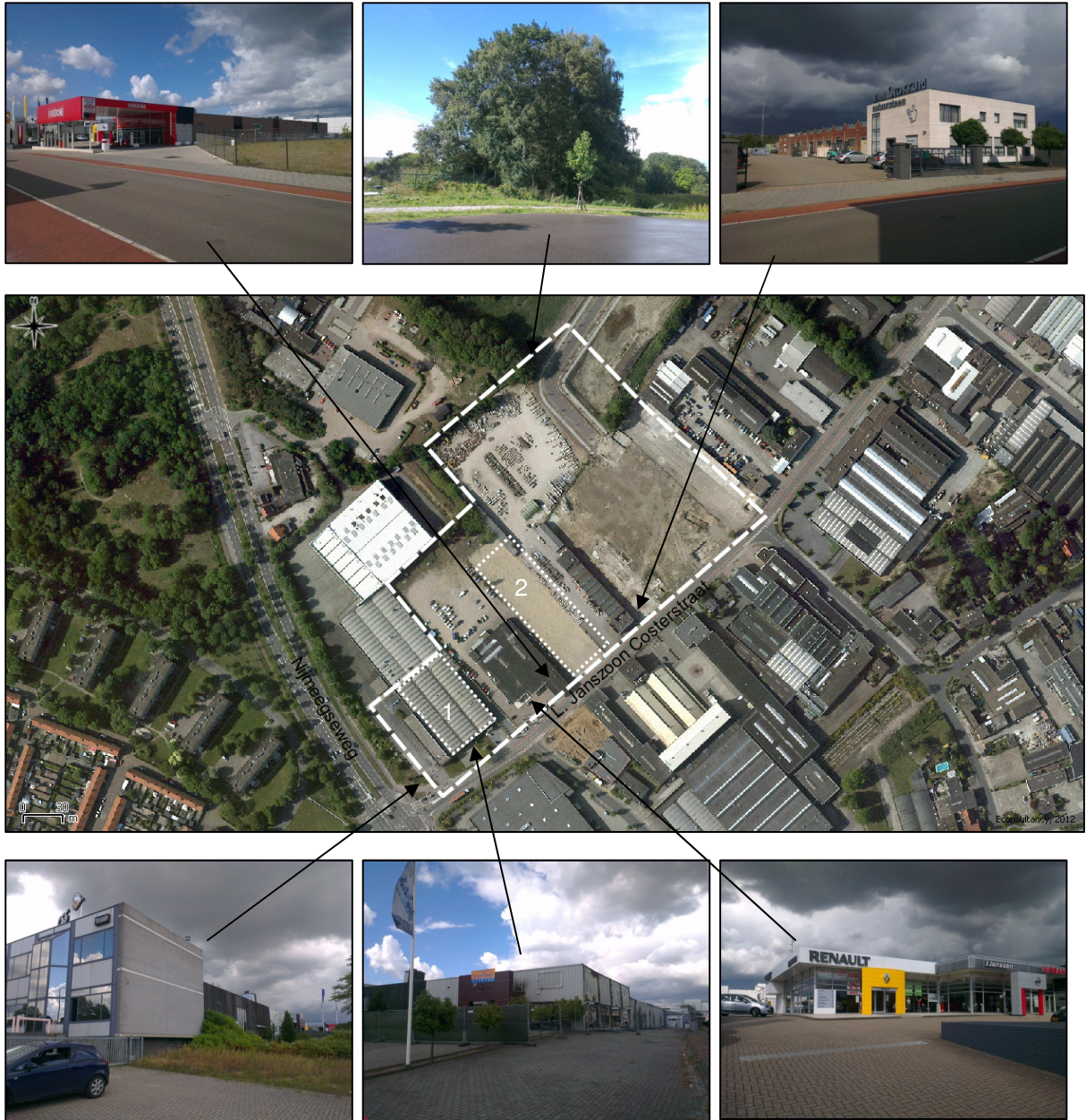
Figuur 2 Luchtfoto met de schematische begrenzing van de onderzoekslocatie te Venlo. De loods nr.1 is recentelijk uitgebrand. De bebouwing nr. 2 is reeds verwijderd. Figuur 3 t/m 8 betreffen impressiefoto's van de onderzoekslocatie.
