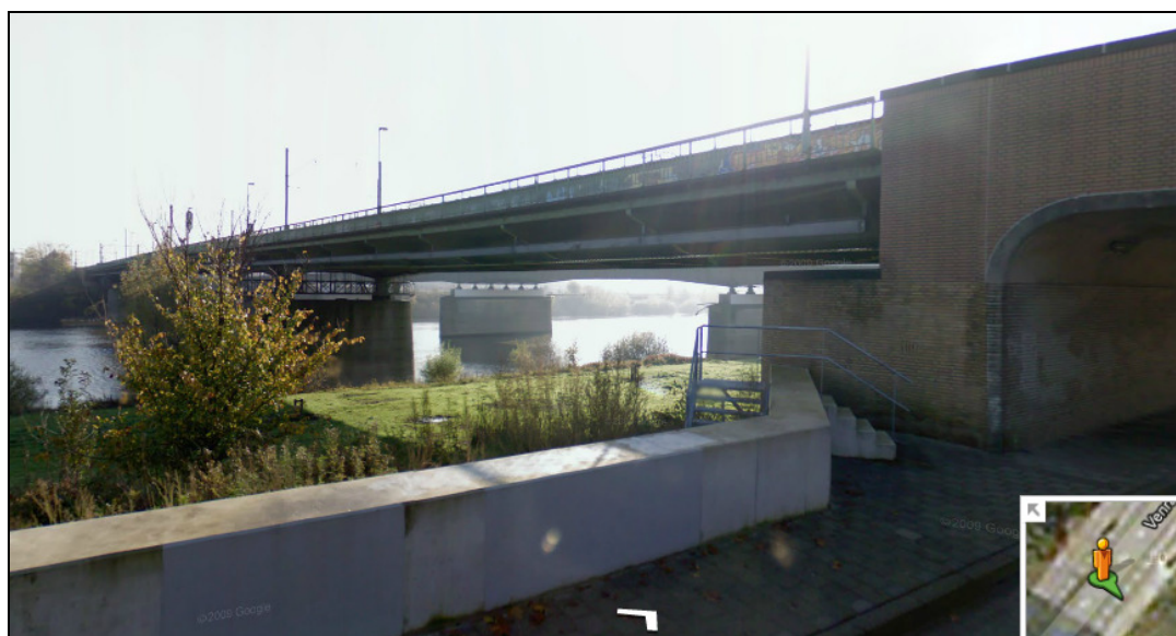
Afbeelding 2.2. Zicht op spoorbrug noordzijde, eronder EHS
