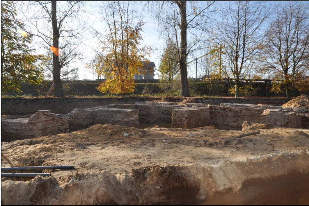
Afb. 13 De punt van bastion 2, met de steunberen die oorspronkelijk met een aarden wal bedekt waren (foto Buro4 Monument en Ruimte)
