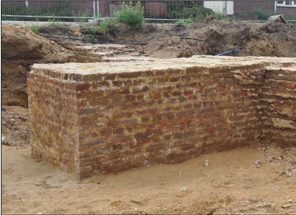
Afb. 9 In twee fasen opgemetselde steunbeer, met diagonale beëindiging (foto Buro4 Monument en Ruimte)
