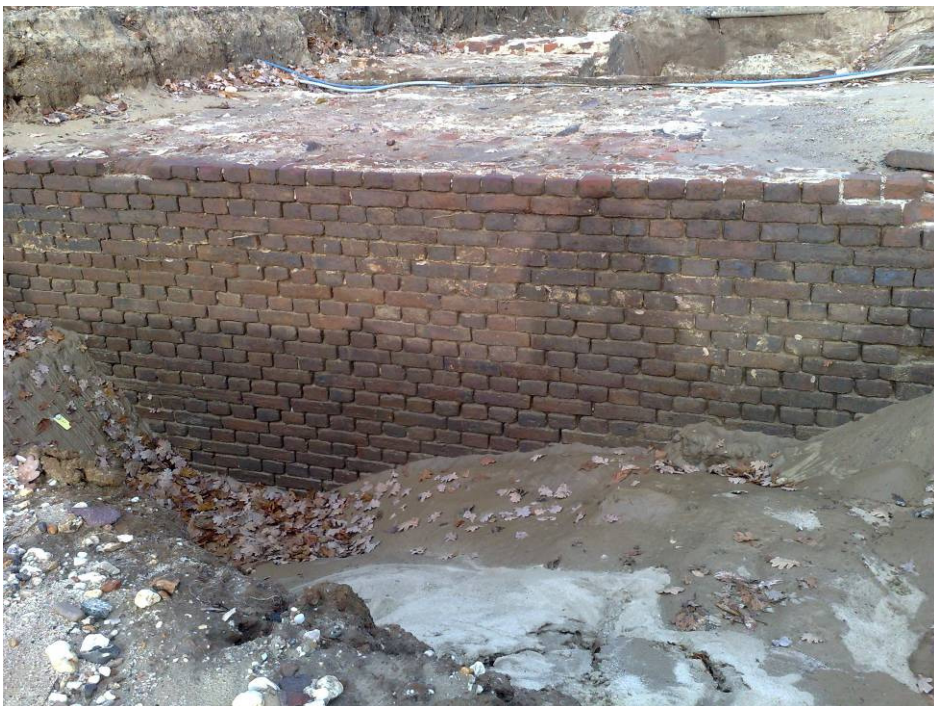
De grachtzijde van de bastionmuur, met een 19 e -eeuwse bakstenen klampmuur
