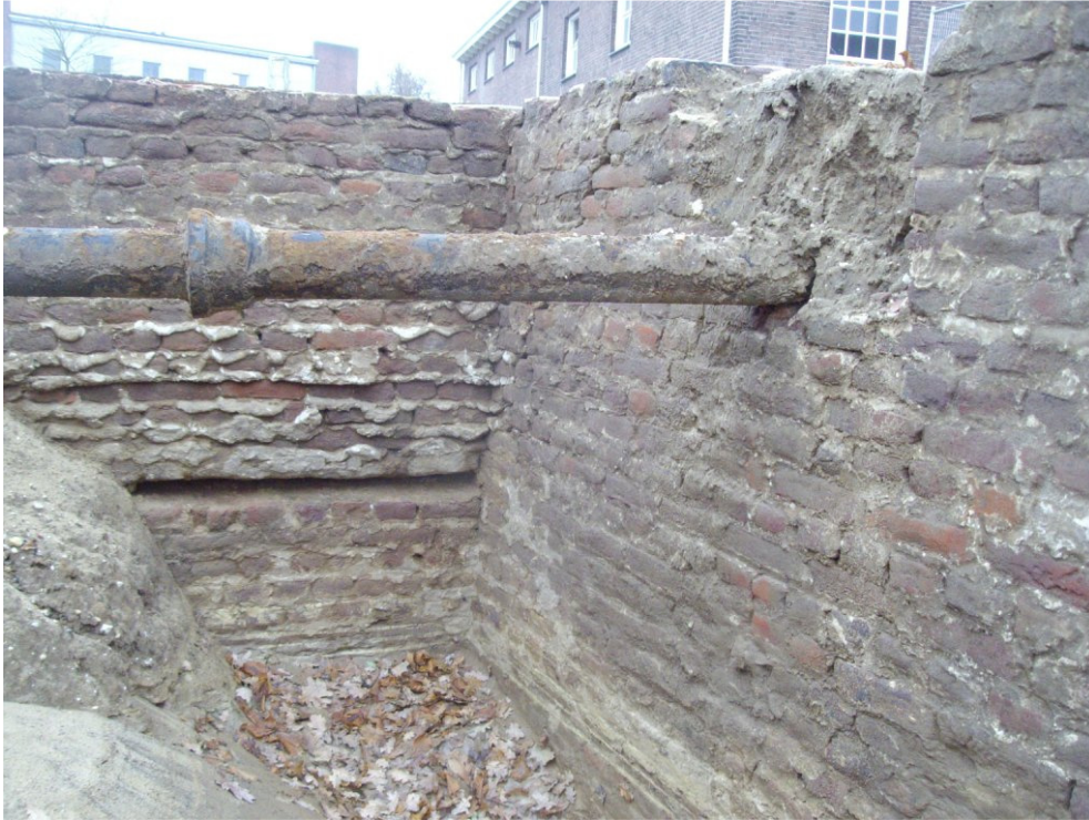
Opbouw van het muurwerk
