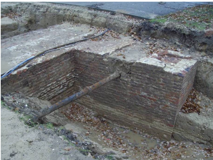
Het opgegraven muurwerk met schildmuur (l) en steunbeer (r)
