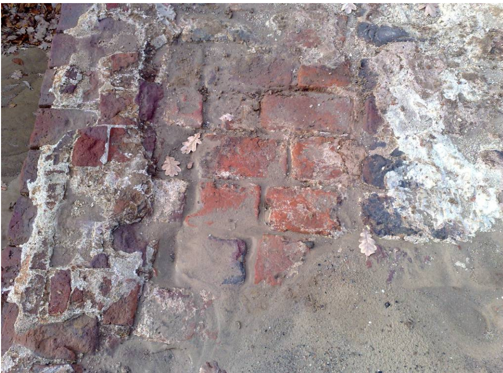
Bovenzijde van het muurwerk, met links de 19 e -eeuwse klampmuur, in het midden een verdikking uit ca.1810 en rechts het oorspronkelijke 17 e -eeuwse muurwerk
