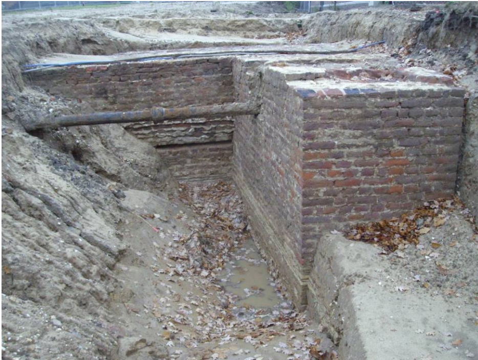
Frontaal aanzicht muurwerk en steunbeer
